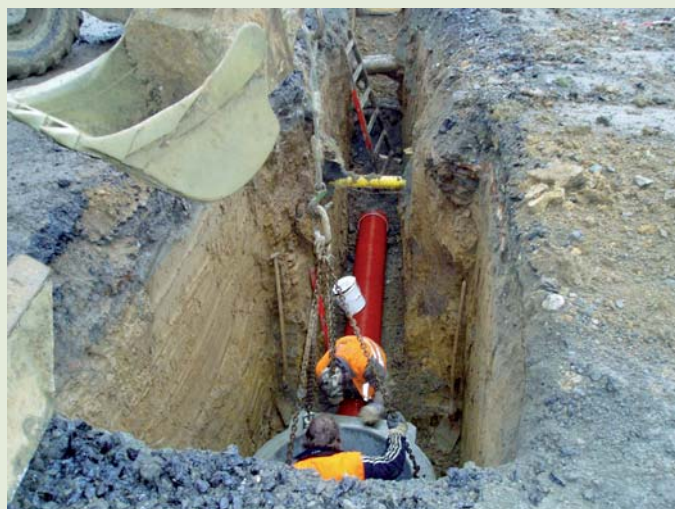
Drahotuše - stavba kanalizace
