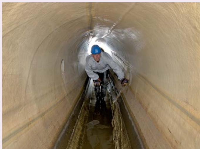
Rekonstruovaná kanalizace v Přerově - Komenského ul.
