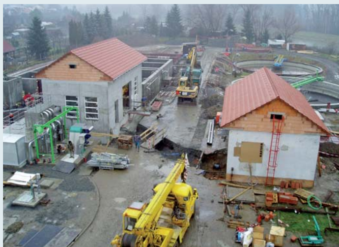
Rekonstrukce ČOV Lipník n.B.
