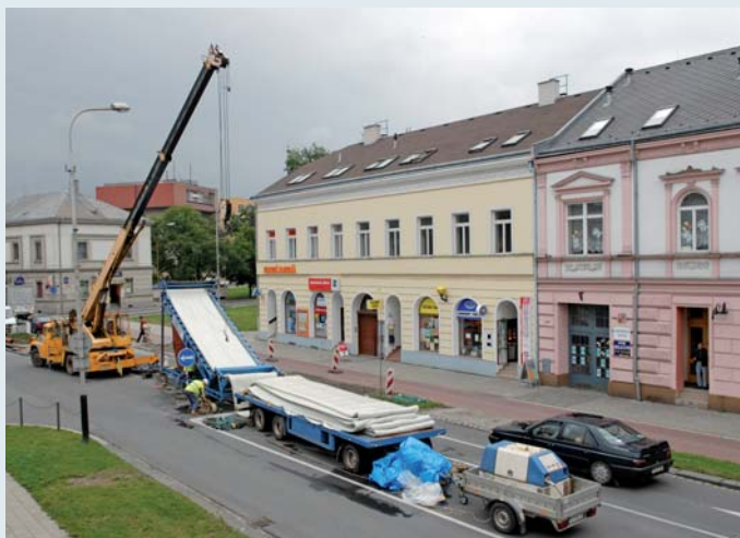
Rekonstrukce kanalizace v Přerově - Komenského ul.
