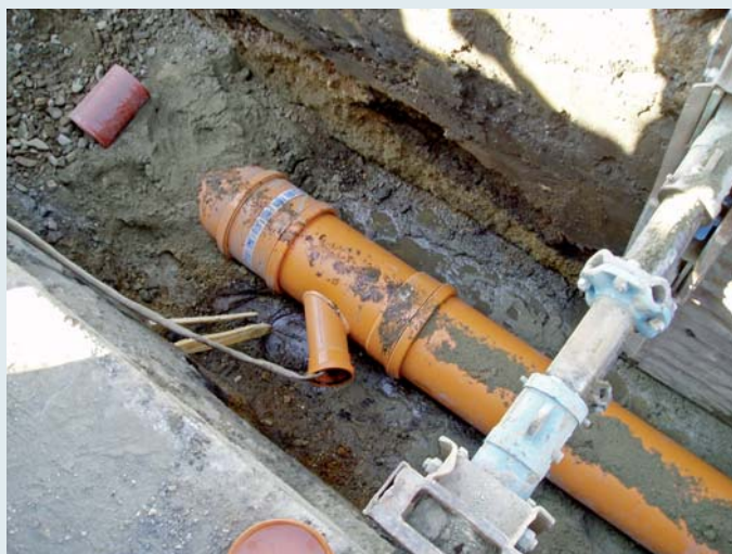
Kojetín - rekonstrukce kanalizace
