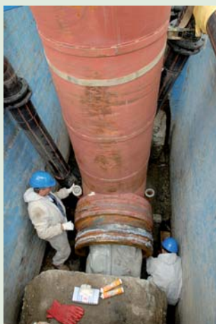
Přerov - vložkování kanalizace
