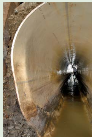
Přerov - vložkování kanalizace
