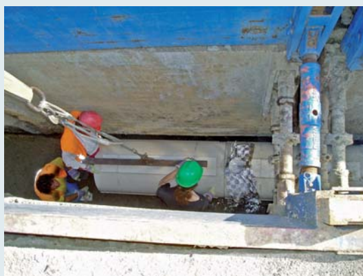
Přerov - stavba kanalizace na nábřeží PFB
