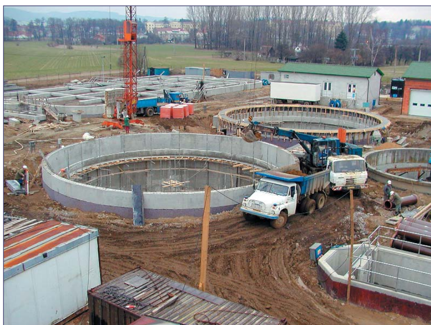
Výstavba nových objektů na ČOV Hranice.
