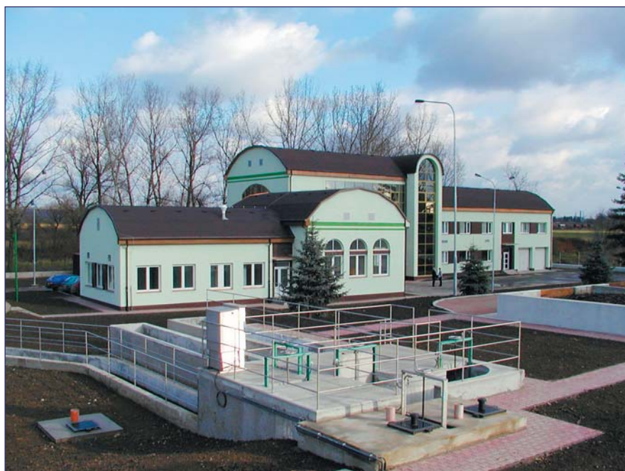
ČOV Přerov – provozní budova, laboratoř a dílny.
