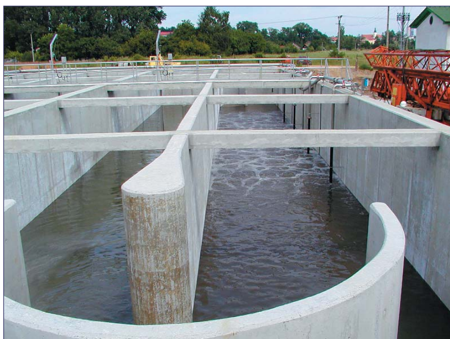
ČOV Hranice – nové aktivační nádrže
