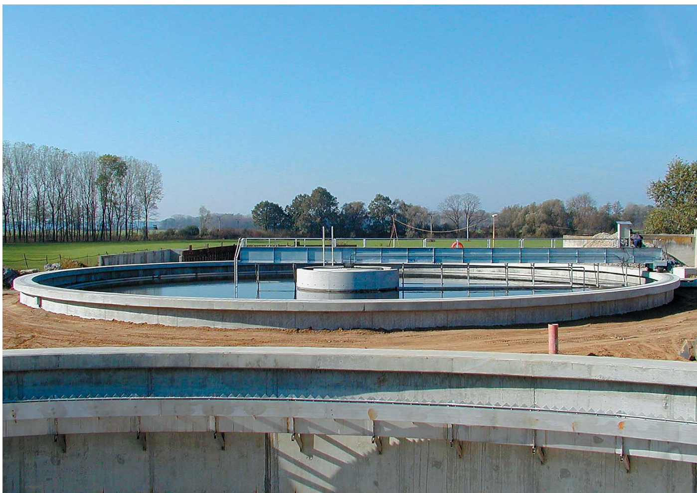
ČOV Přerov – nové dosazovací nádr
