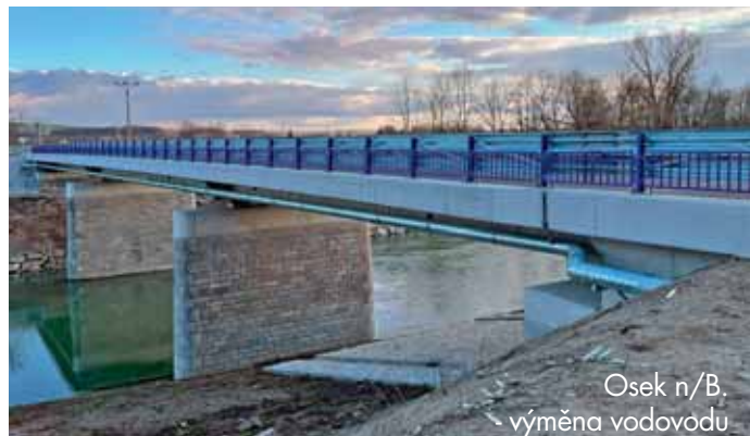
Osek n/B. - výměna vodovodu
