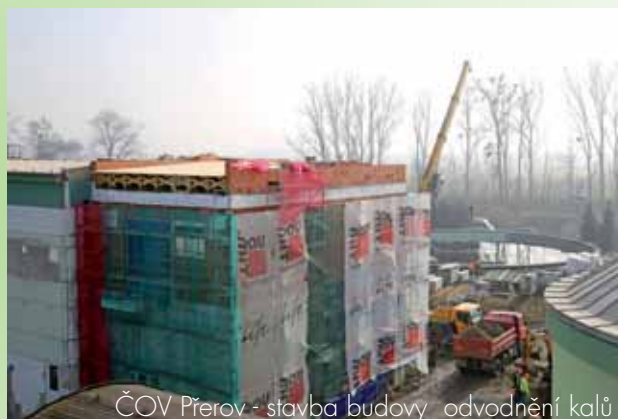
ČOV Přerov - stavební práce
