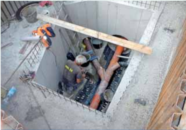
Sběrač NA - obkládání dna šachty čedičem
