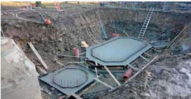
Lhotka u Hranic - základová deska ČS a ČOV
