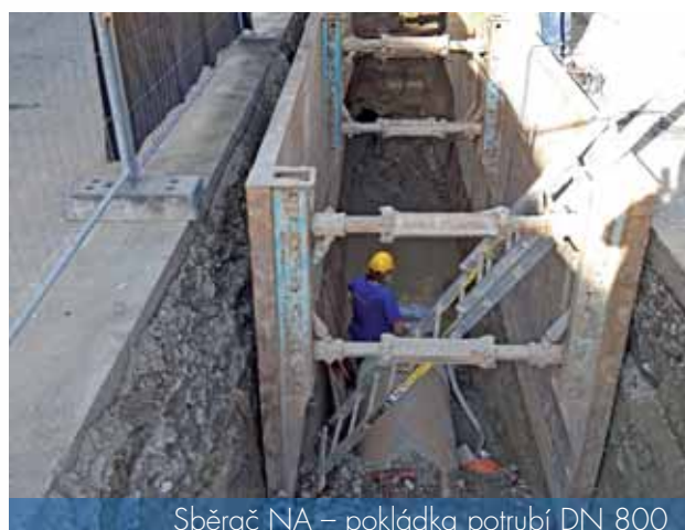
Sběrač NA – oprava potrubí DN 800
