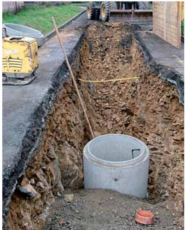
Dolní Újezd - stoka AC - výkop v kamenitém podloží
