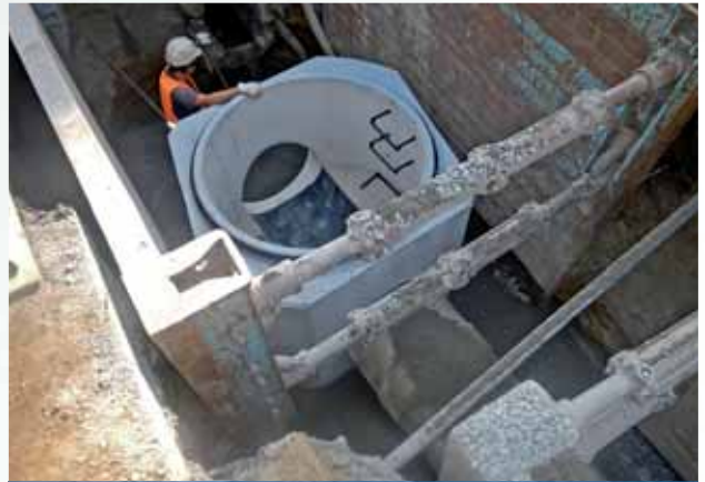
Sběrač NA - uložení šachtového dna
