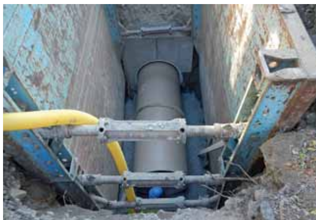
Stavba kanalizace - sběrač Z
