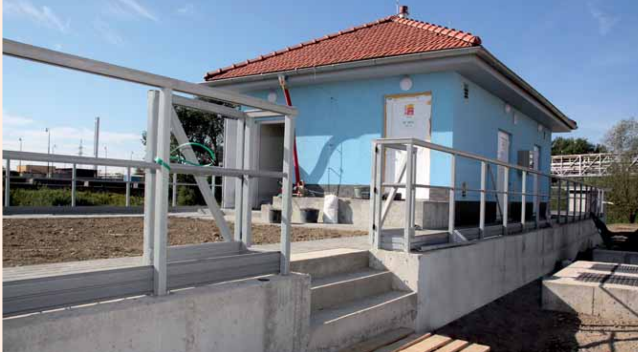
Retenční nádrž RN - OK 1 Na
