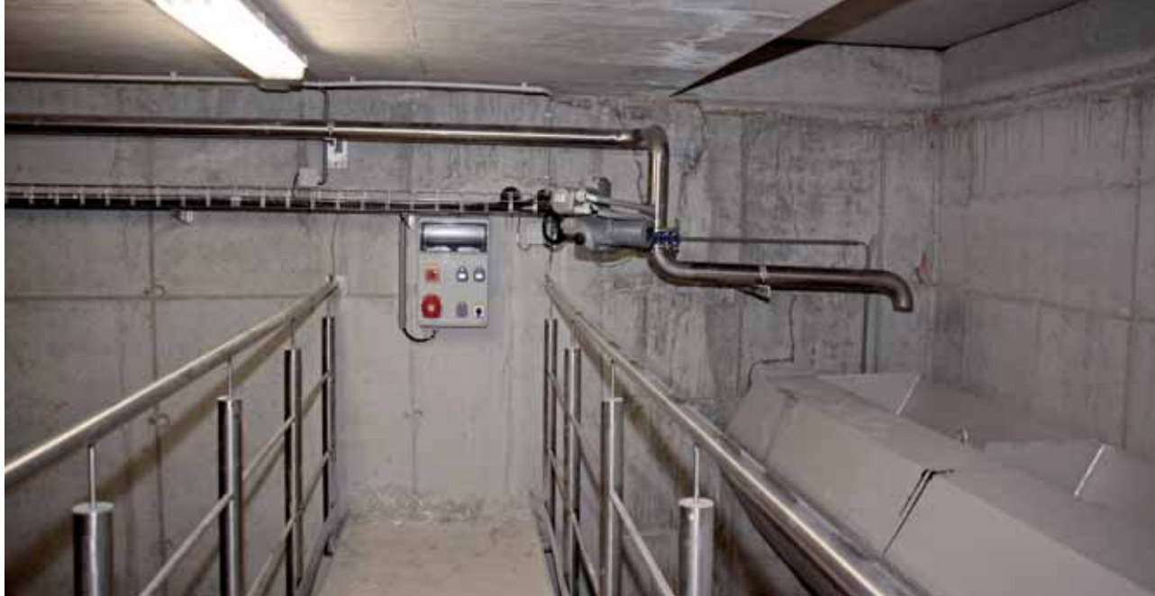
Vyplachovací klapka v retenční nádrži RN - OK 1 Na
