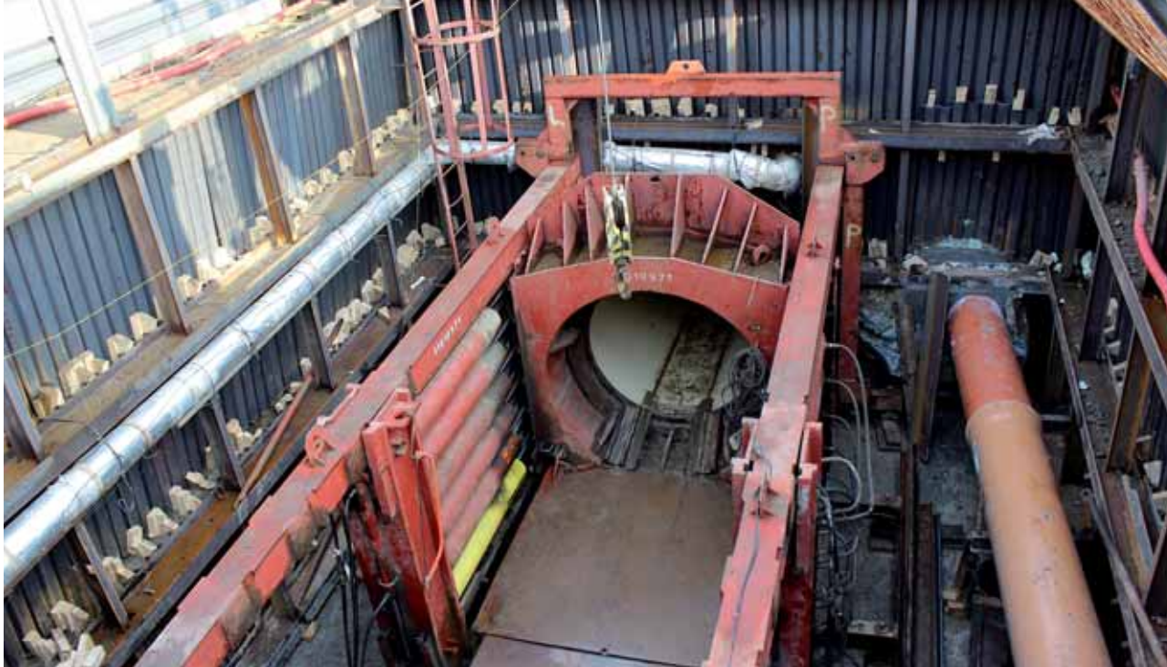
Provádění protlaku DN 1400 pod železniční tratí
