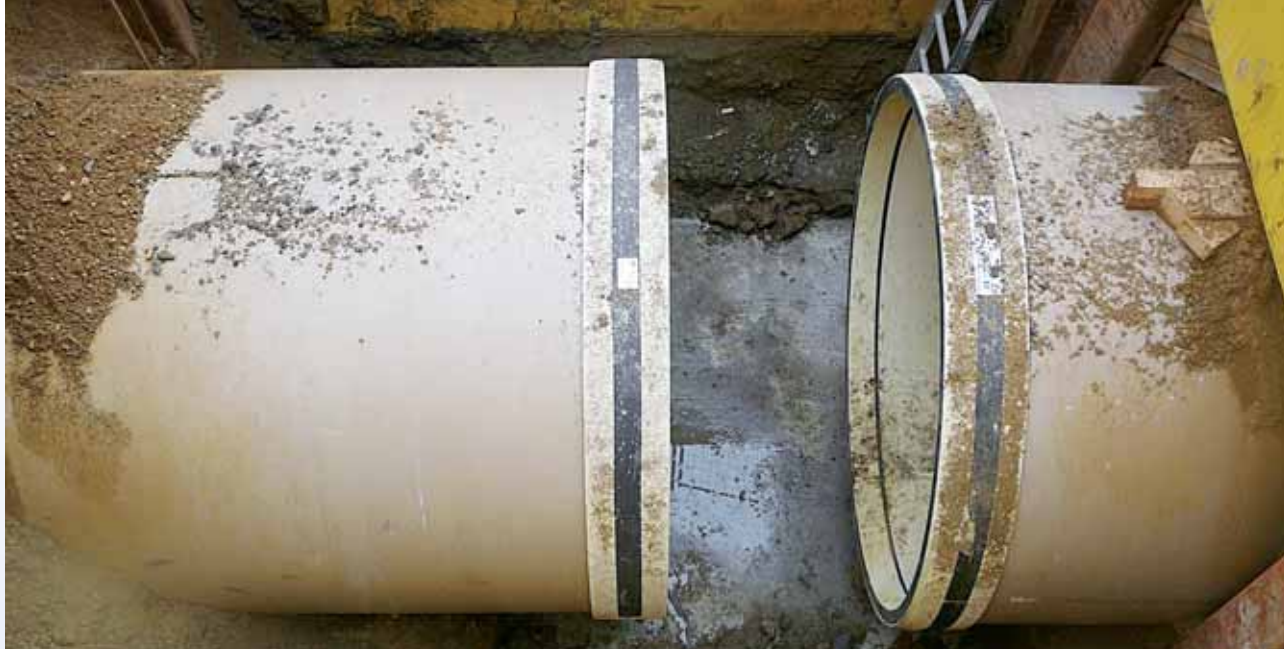
Stavba kmenové stoky A DN 2400
