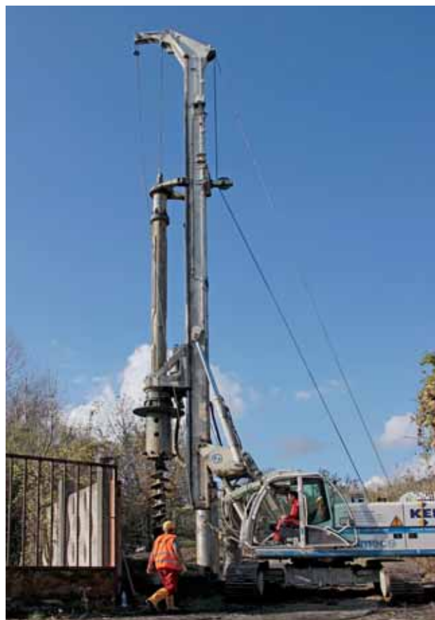
Provádění hydrovrtů
