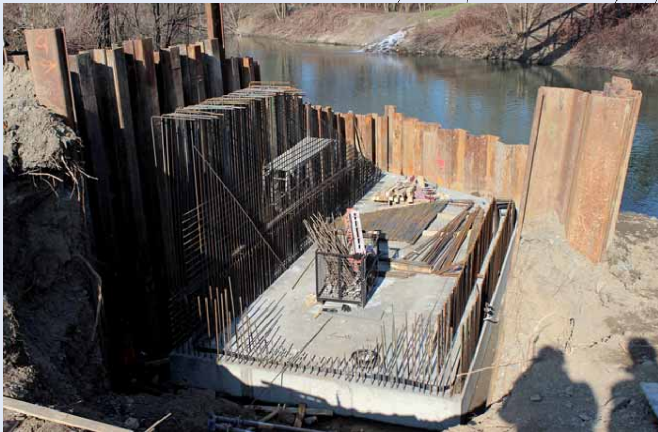
Armování výstřního objektu na levém břehu řeky Bečvy
