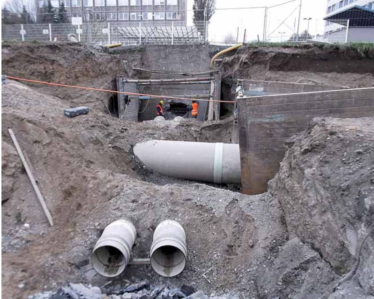
Křížení kmenové stoky N s potrubím z Prechezy
