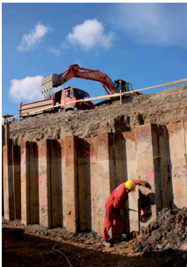
Provádění kotvené šětové stěny pro RN na pravém břehu řeky Bečvy
