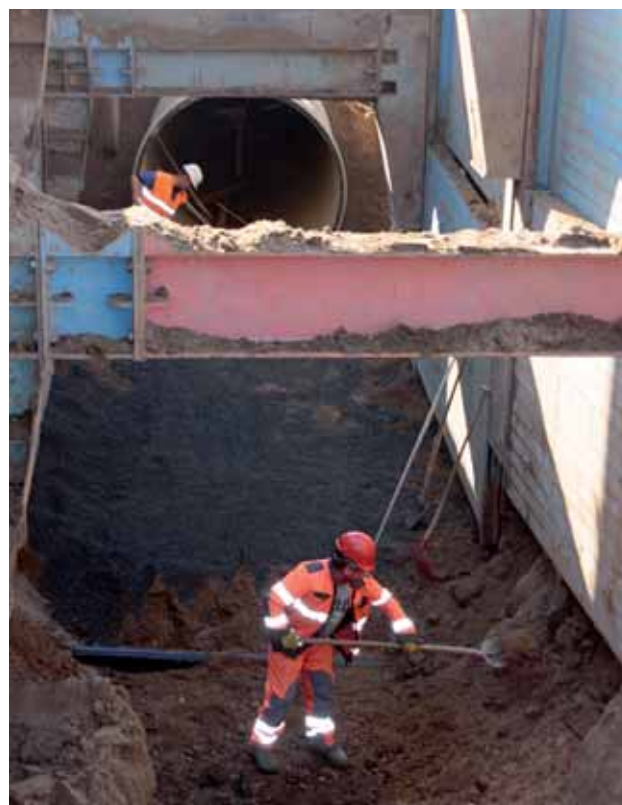
Stavba kmenové stoky DN 2400 na Tovačovské ulici
