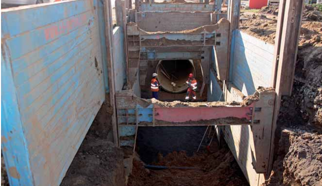
Stavba kmenové stoky A DN 2400 na Tovačovské ulici
