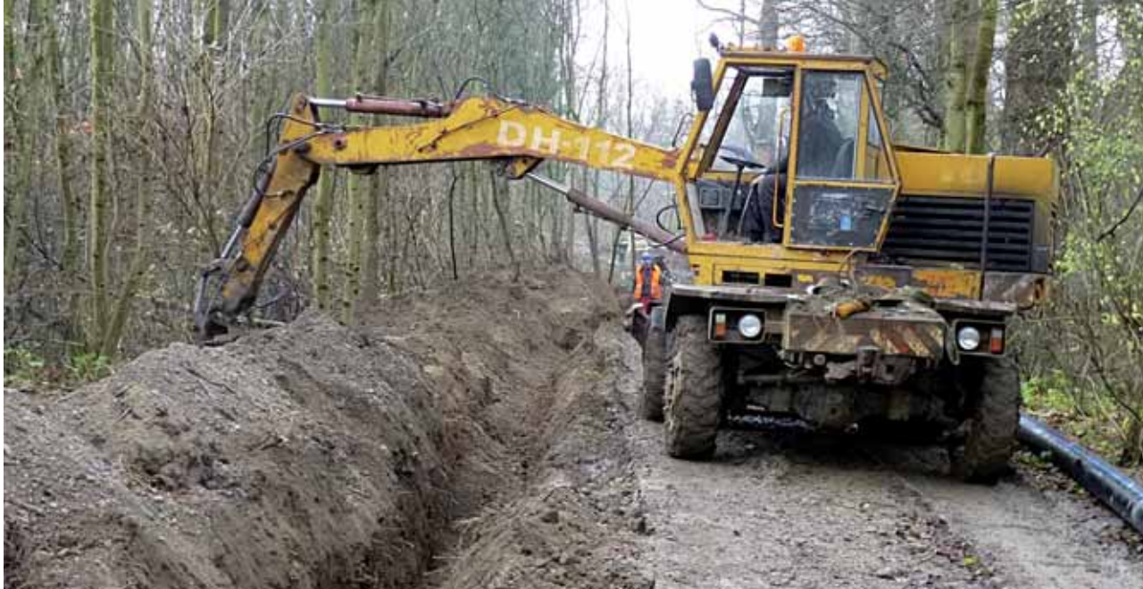
Stavba výtlačného řadu z Kozlovic
