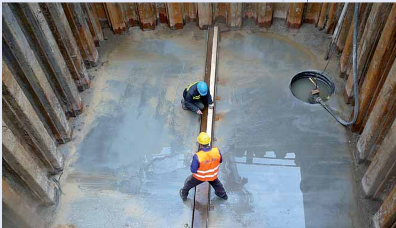
Příprava pro osazení razicího štítu
