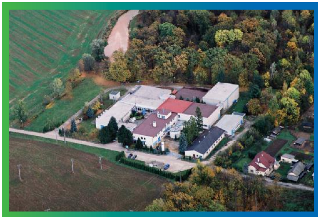
Úpravna vody Troubky
