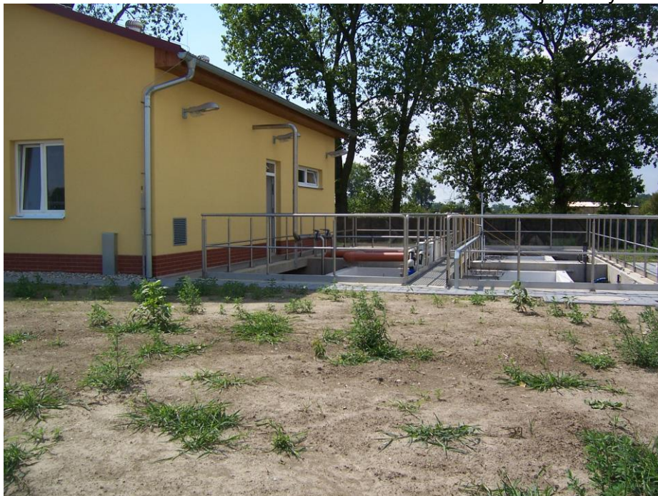
Obr. 1 Provozní budova ČOV + venkovní část čistírenské jednotky
